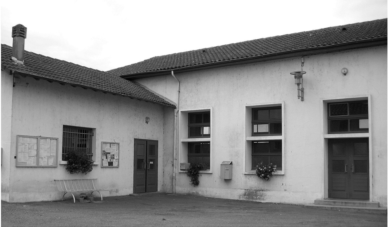
Le foyer et la mairie actuels à l'emplacement de la première école construite en 1842 et en service jusqu'en 1932
